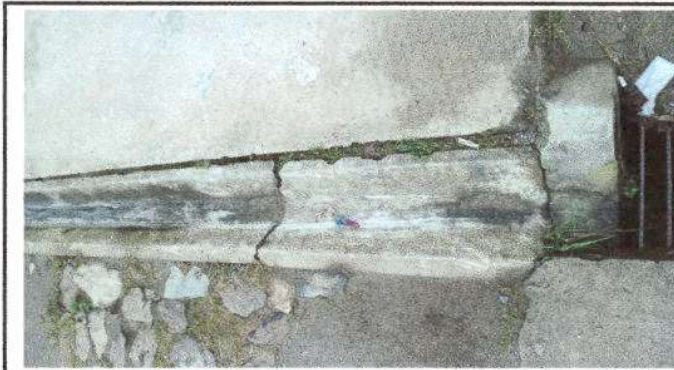
Foto 3: Cuneta para drenar el agua ya que el agua se enpila por las fuertes lluvias. Cantidad 36 metros.
